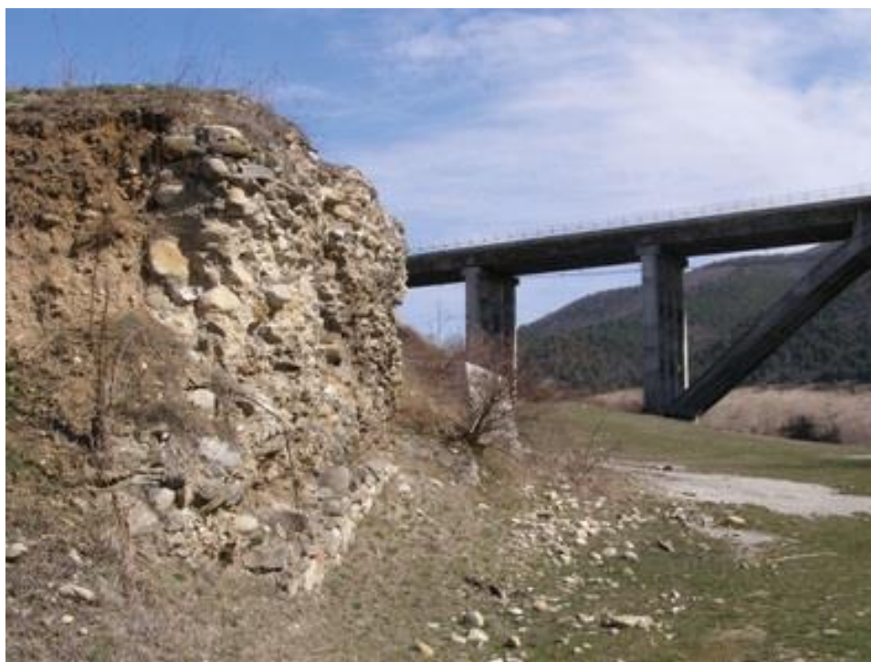
Ruinele Podului roman de la Ohaba de Sub Piatră
