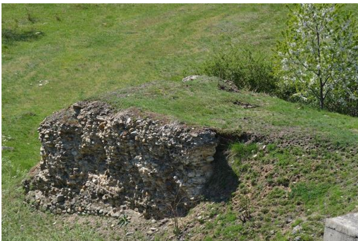
Ruinele Podului roman de la Ohaba de Sub Piatră
