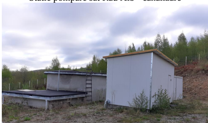
Statie tratare apa din satul Pestera
